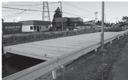
ボックスカルバート付近～道路の早期整備を～
