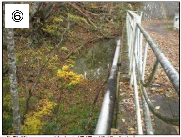
⑥ 名称等: D2 焼山小溪橋 添架パイプ 種類: 全景 備考: 上流側
