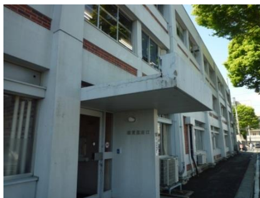
本庁舎本館外観
