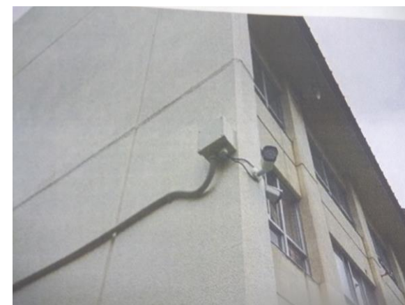
防犯カメラ設置例（ちとせ小学校）
