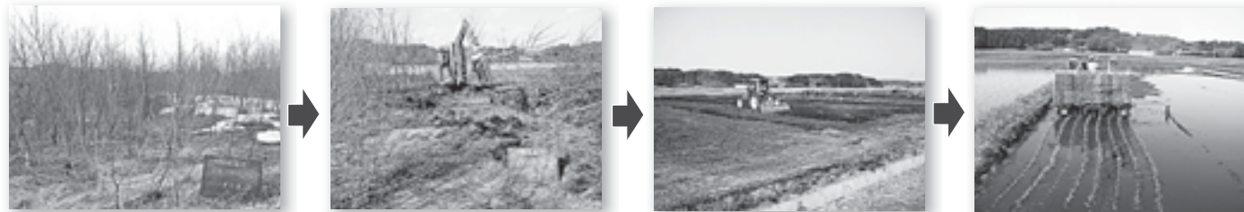
復元前 (ヤナギなどが生い茂っています) 伐根作業 (グラップルで根を抜き取ります) 耕起作業 (ブルドーザーで整地後、耕起します) 復元後 (飼料用米の作付けを行いました)
