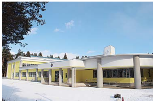
▲四和中学校のグラウンドでは、今年4月に開校される四和小学校(中学校と併設)の工事が着々と進められています。
