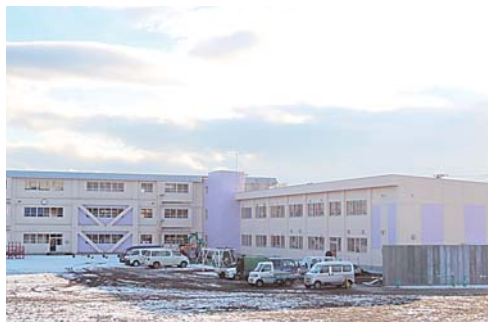
▲藤坂小学校では、耐震改修を行い耐震化を図るとともに特別教室棟の改築工事を実施(写真右側の棟)。良好な学習環境の整備に努めています。
