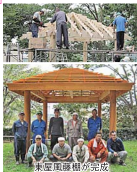
東屋風藤棚が完成
