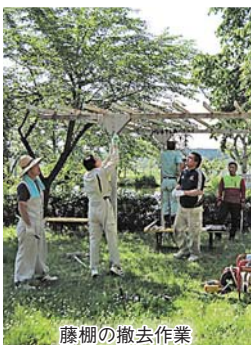
藤棚の撤去作業
