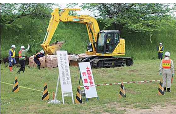
崩壊土砂等撤去および大型土のう設置訓練。それぞれの役割を確認し、迅速な連携をみせていました
