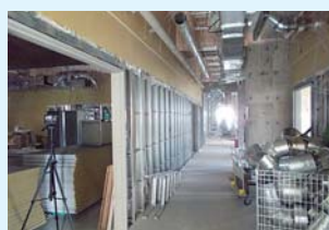
議場廊下部分
