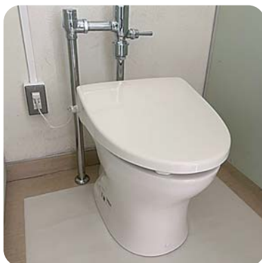
改修後のトイレ
