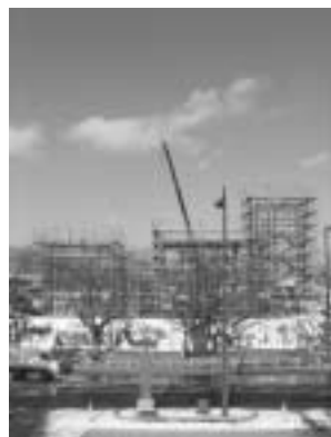
工事現場(12月中旬)
